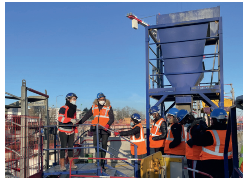
Visite du chantier de la future gare de Noisy-Champs (93) par les stagiaires du Réseau Étincelle
